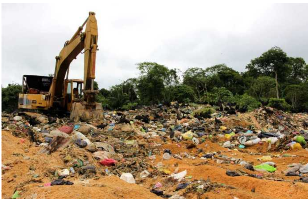
Foto 3. Relleno sanitario "El Treinta"
