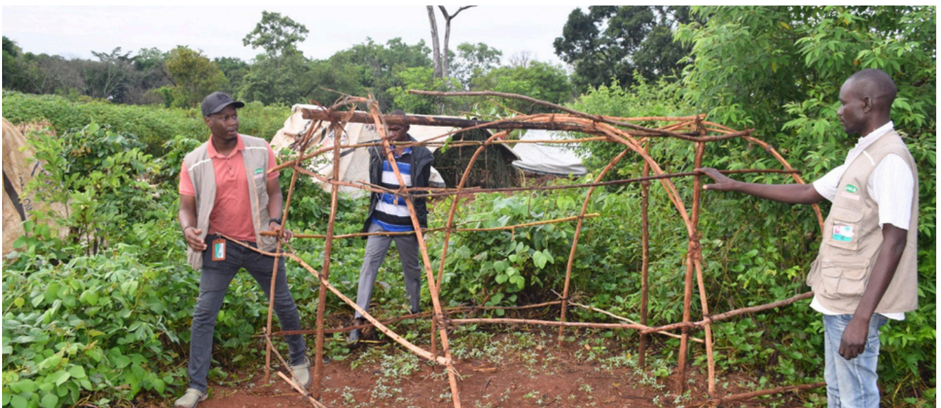
A equipa da YEDA constrói estruturas de emergência na Equatória Ocidental. Crédito da fotografia: YEDA
