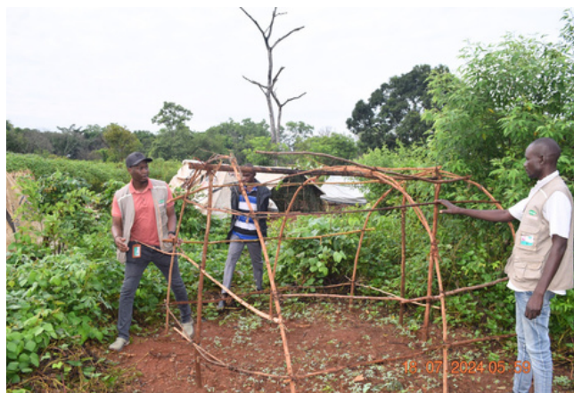
L'équipe de YEDA construit des abris d'urgence dans l'Équatoria occidentale. Crédits photo : YEDA
