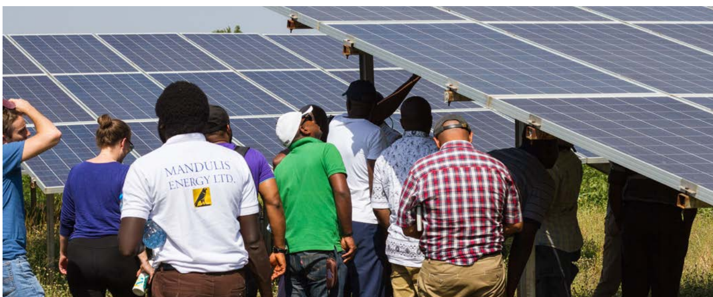
Image : © LEDES GP | Visite d'un réseau électrique rural à énergie solaire, Nigéria.
