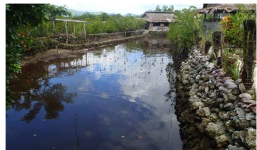
1 3 Image : © World Fish | Mesures hybrides : une combinaison de protection côtière « en dur » et de mesures fondée sur les écosystèmes.
