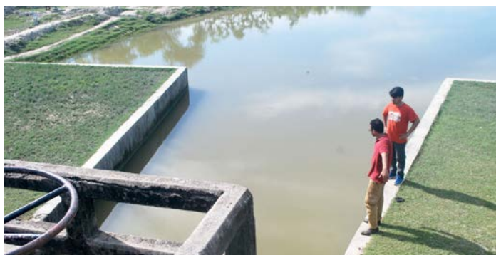
4 Image : © REACH | Technologie des polders pour gérer l'eau dans les zones de progression côtière.
