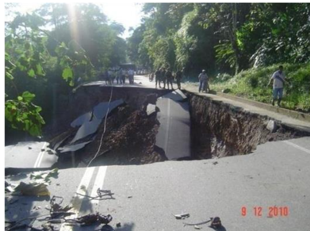
Imagen 2: Carretera colapsada por erosión entre Bucaramanga y Barrancabermeja. Fuente: Ministerio de
