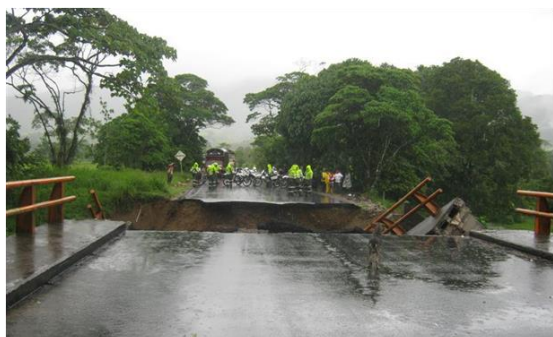
Imagen 1: Desplome del puente “El Mochilero” cerca de San José del Fragua por socavación en los estribos.
